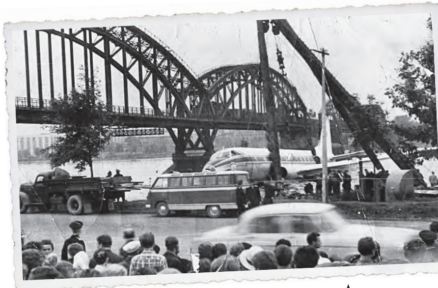
▲ Борт Ту-124 эвакуируют после успешного приводнения на Неву 21 августа 1963 года
