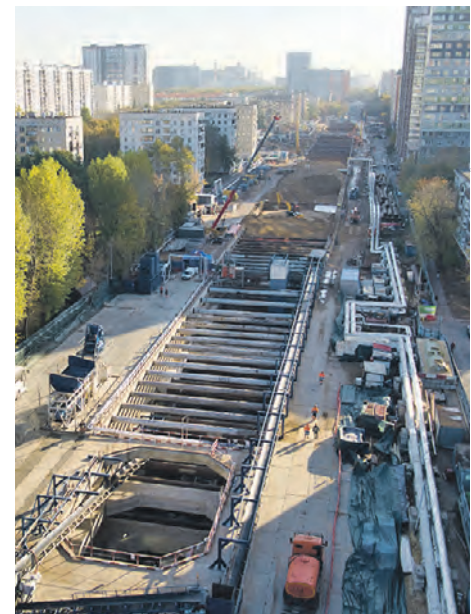
Перегонный тоннель Рублево-Архангельской линии метро
