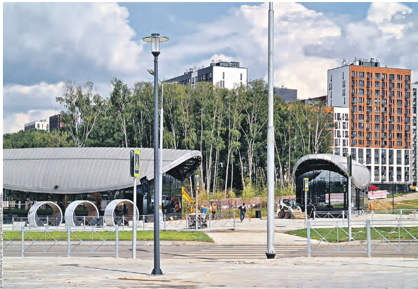
9 августа. Станция «Потапово» Сокольнической линии метро
