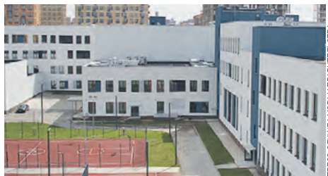
25 апреля. Рязановское. Новый корпус школы № 2083
