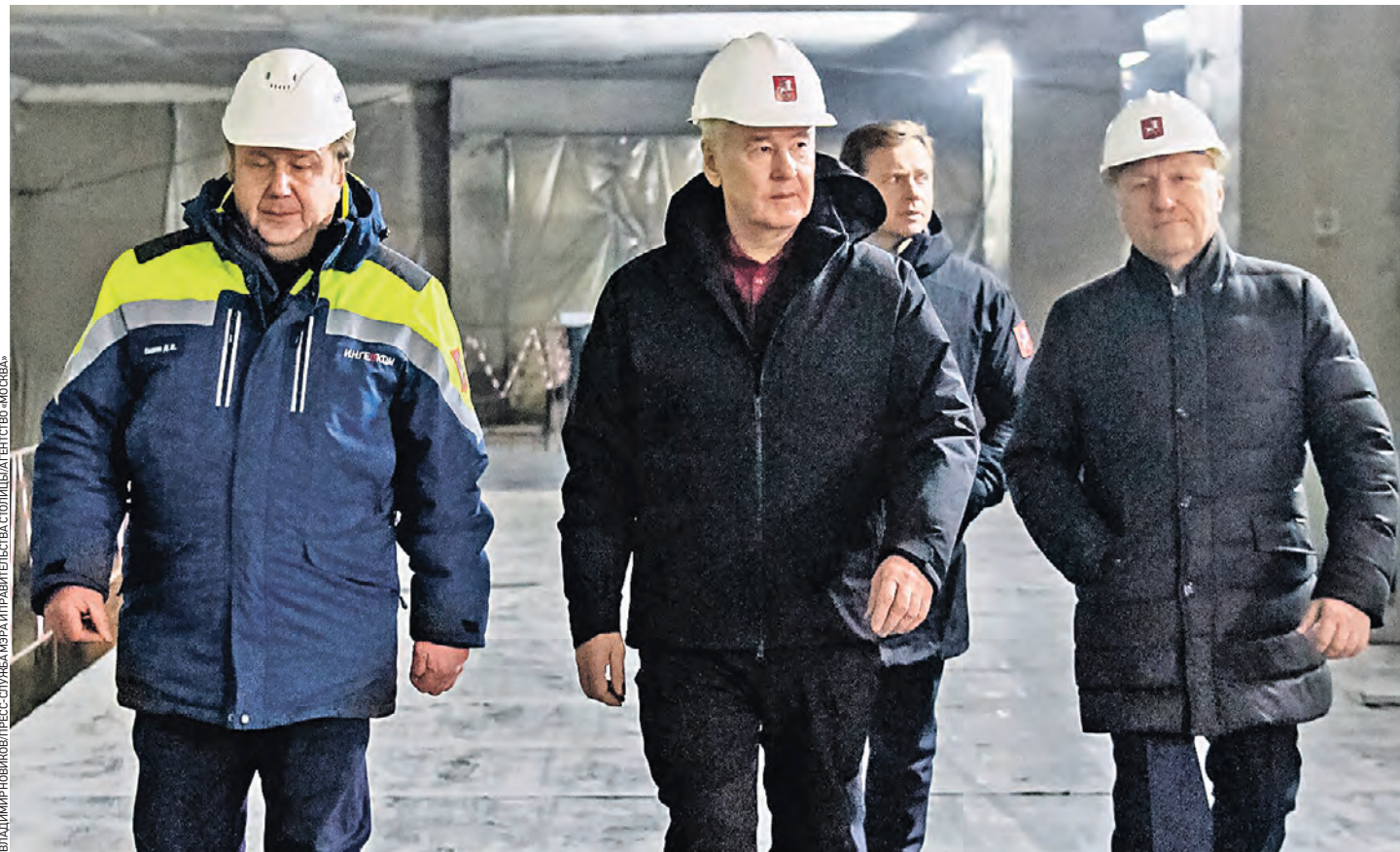
26 февраля. Мэр Москвы Сергей Собянин (в центре) и заместитель мэра Москвы по вопросам градостроительной политики и строительства Андрей Бочкарев (справа) во время осмотра строящейся станции «ЗИЛ» Троицкой линии метро
