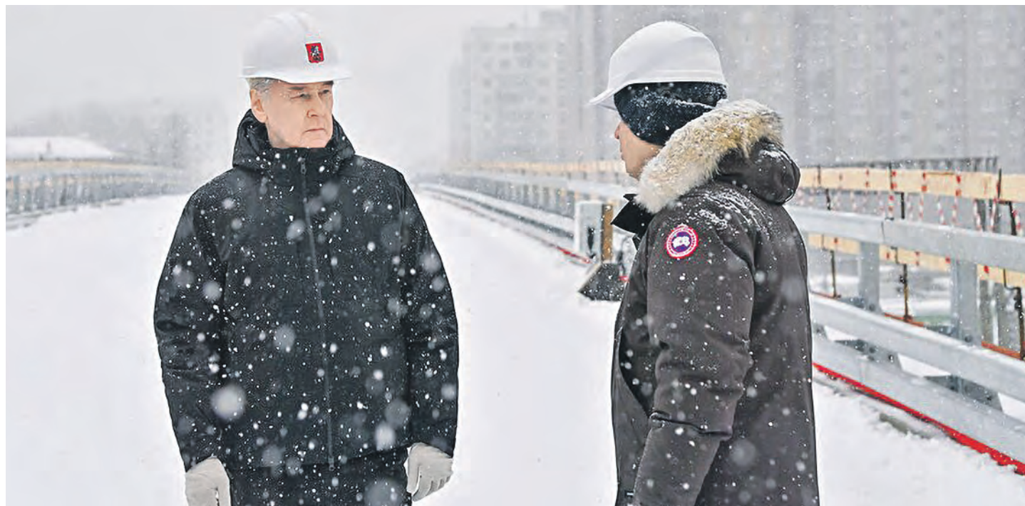
15 января. Мэр Москвы Сергей Собянин во время осмотра строящегося путепровода через пути первого маршрута Московских центральных диаметров
