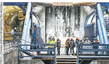
Работы на Троицкой линии метро активно ведутся
