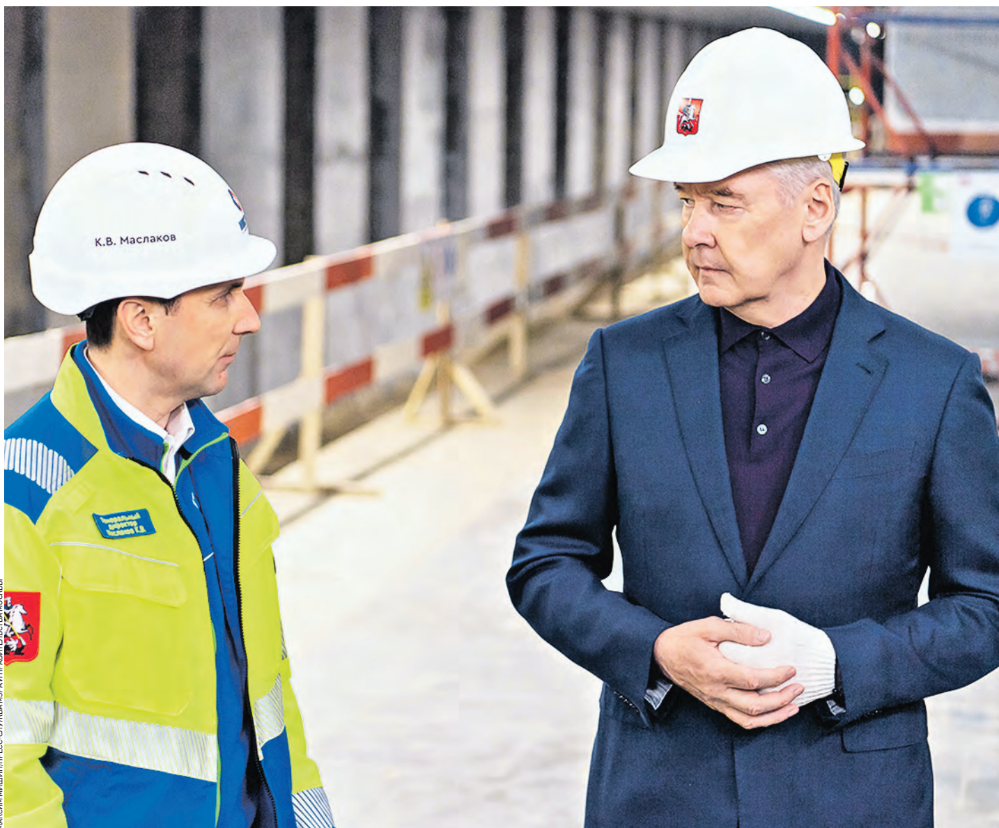
23 мая 2022 года. Мэр Москвы Сергей Собянин (справа) и гендиректор МИП-Строй № 1 Константин Маслаков осмотрели ход строительных работ на станции «Текстильщики» БКЛ
