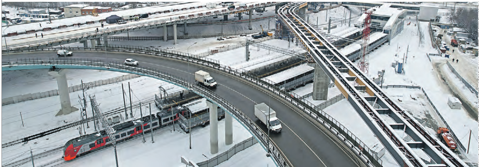
24 января 2022 года. Москва. Строительство участка Юго-Восточной хорды от шоссе Энтузиастов до Рязанского проспекта.
