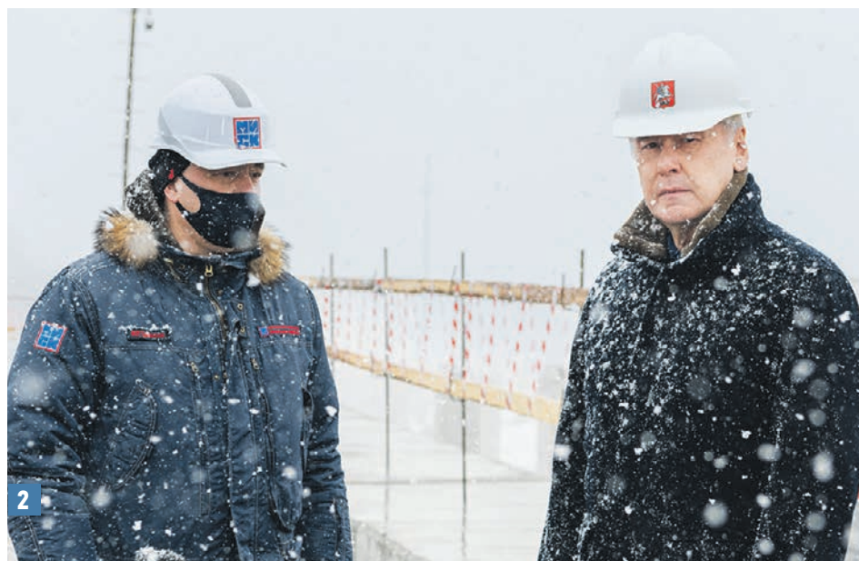
22 марта 2021 года. Мэр Москвы Сергей Собянин и генеральный директор компании-подрядчика Фарит Хайдаров (2) во время осмотра строительства участка Юго-Восточной хорды (1)
