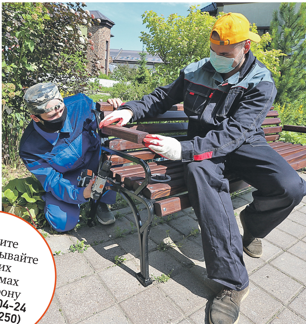
23 июня 2020 года. Краснопахорское. Рабочие заканчивают ремонт лавочки во дворе на улице Радужная села Былово
