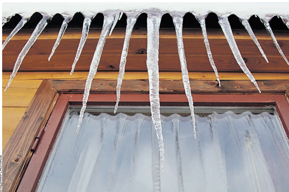
Сосульки промышленные альпинисты должны убирать по мере их образования, счищать с крыш снег в течение двух дней после снегопада
