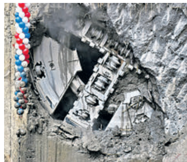
29 ноября 2016 года. Строительство станции метро «Боровское шоссе», выход тоннелепроходческого щита
