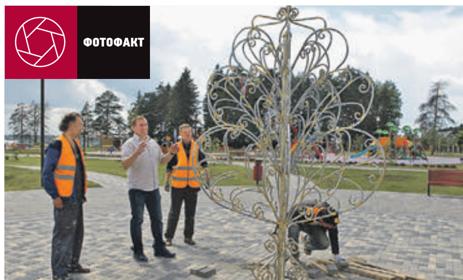
3 июня 2016 года. Новофедоровское. Рабочие устанавливают Дерево любви и крепкого брака
