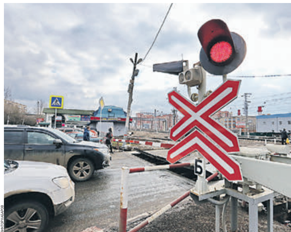
13 января 2015 года. На переезде в Щербинке жители вынуждены терять много времени. Через два года тут будет эстакада
