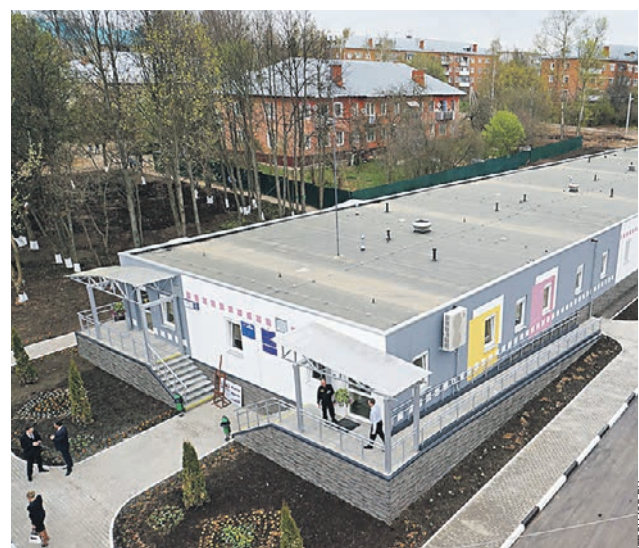
Модульные поликлиники. Девять месяцев — и поликлиника готова. Здания собирают из готовых модулей со стенами, мебелью и медицинским оборудованием.
