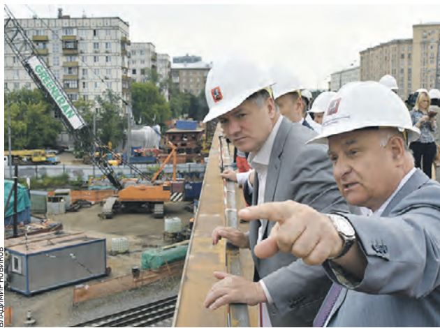
15 июня 2015 года. Заммэра Марат Хуснуллин (слева) осматривает ход реконструкции Волоколамского путепровода
