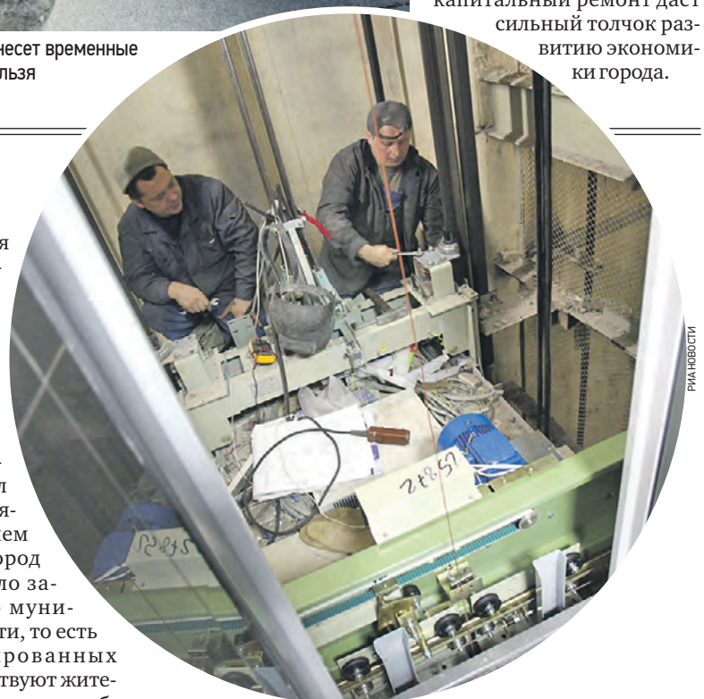
Ремонт и замена лифтов — важный этап капитального ремонта многоквартирных домов
