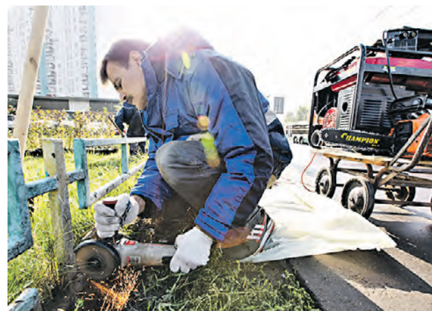
18 апреля 2015 года. После демонтажа металлических ограждений на их месте высадят деревья
