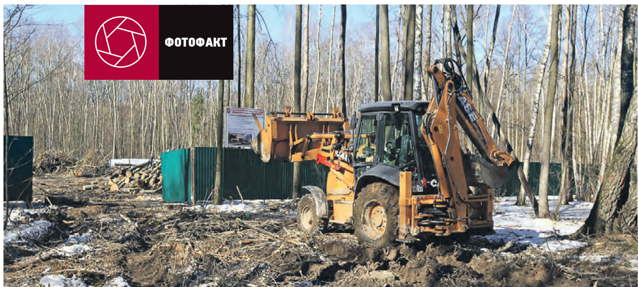
14 марта 2015 года. 12:50 Троицк. Техника расчищает площадку под строительство будущей подстанции скорой помощи
