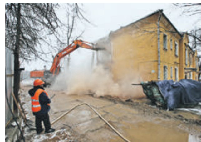
15 февраля 2016 года. Щербинка. Ветхий дом с протекающей крышей сносят. Вместо него появится новый жилой комплекс
