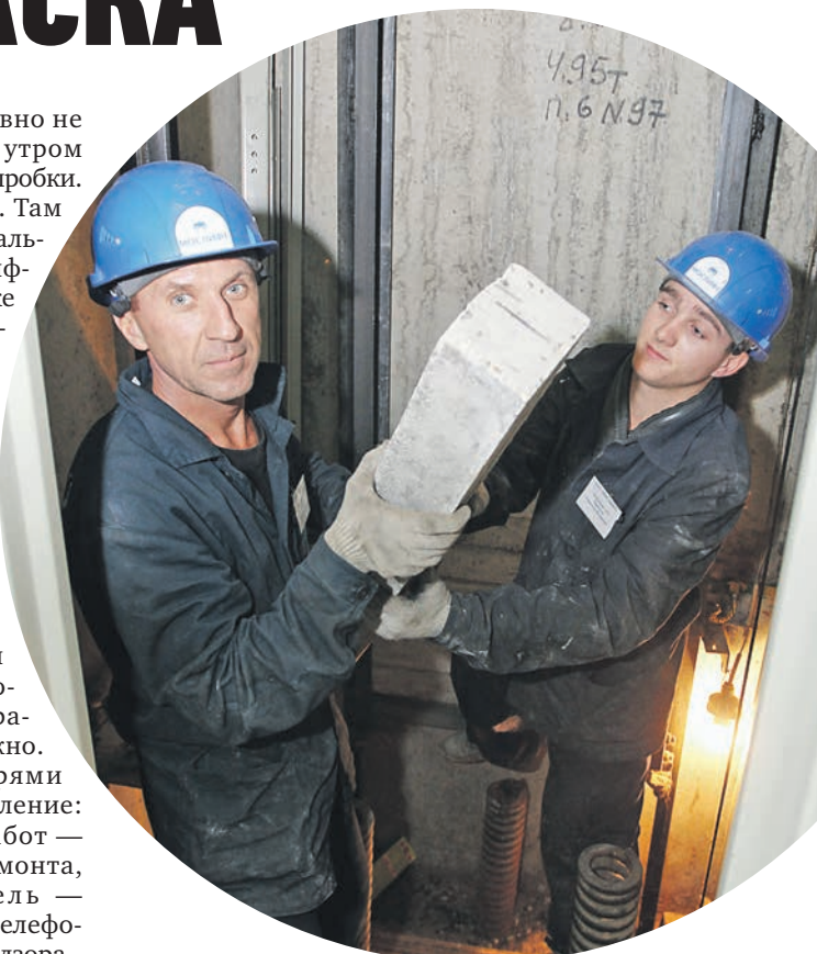
6 октября 2015 года. Монтажники Александры, Харченко и Приходько, знают: работать с новыми лифтами — в кайф
